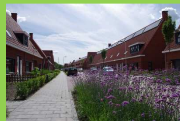
Herstructurering sociale huur - Noorderhoek Sneek
